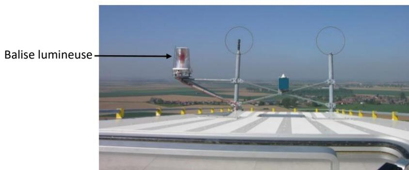
Figure 24: Système de balisage lumineux (Source : ECOTERA)
